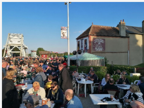
Le café Gondrée et le nouveau pont qui a remplacé en 1994 celui qui était en place en 1944.
